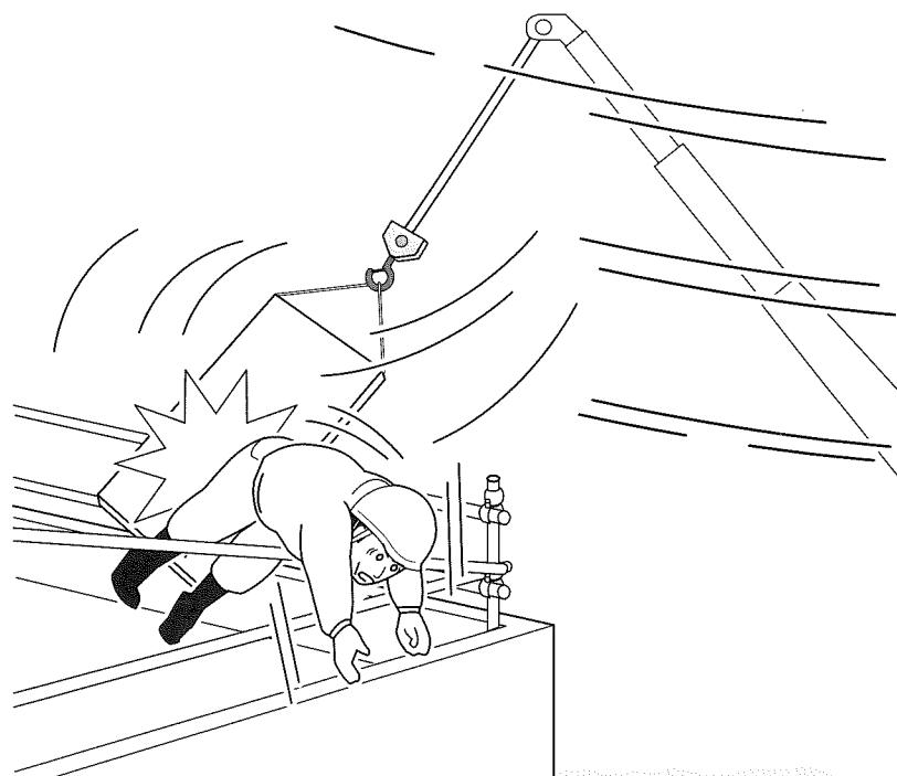
『災害のあらまし』高さ約8mの工場屋上の集じん器に極板を設置するため、地上の移動式クレーンで極板を吊り上げていたところ、強風のために吊り荷が振られ、屋上で仮設の手すり越しに身を乗り出してクレーン運転者に合図を送っていた被災者に極板が当たり、そのはずみで手すりが外れ墜落し、死亡したものです。
